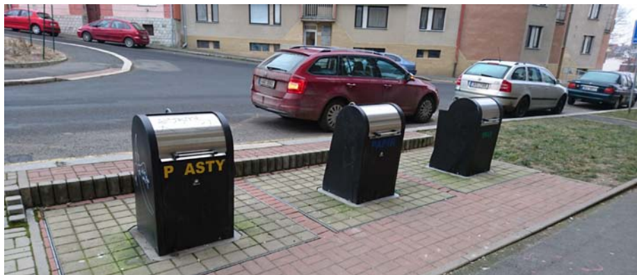
Podzemní kontejnery v liniové zástavbě před bytovým domem
